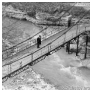
Усам Мадаев на мосту через реку Аргун, который он построил.
