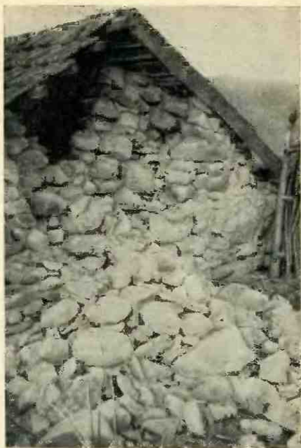
Фиг. 2. С. Советское. Здание склада. Стены из булыжного камня на глиняном растворе
